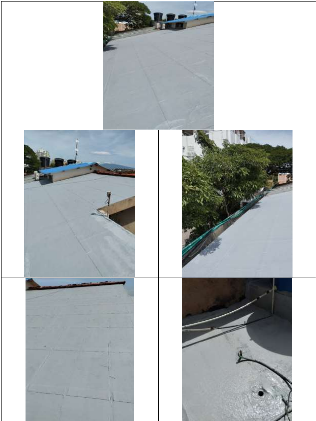
ILUSTRACIÓN 5: IMPERMEABILIZACIÓN FRONTAL DE LA PLACA-TECHO
